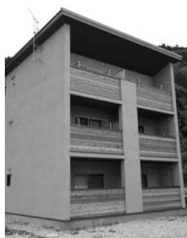
日本で初めてCLTを構造躯体として使用した建物である高知おおとよ製材社員寮(高知県大豊町)(平成26年6月3日)
