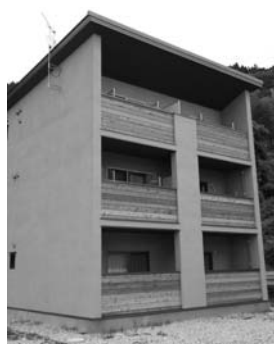
日本で初めてCLTを構造躯体として使用した建物である高知おとよ製材社員寮(高知県大豊町)(平成26年6月3日)
