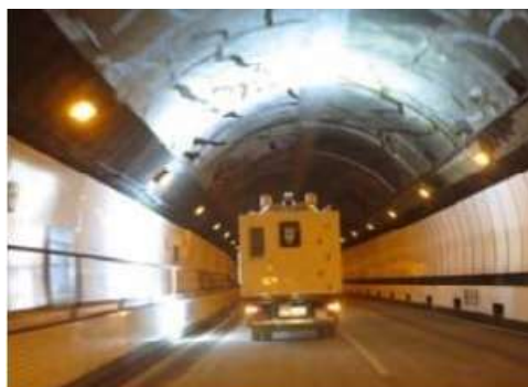
図 17. 計測状況写真（トンネル内空の状態観測、資料集 424 ページ）
