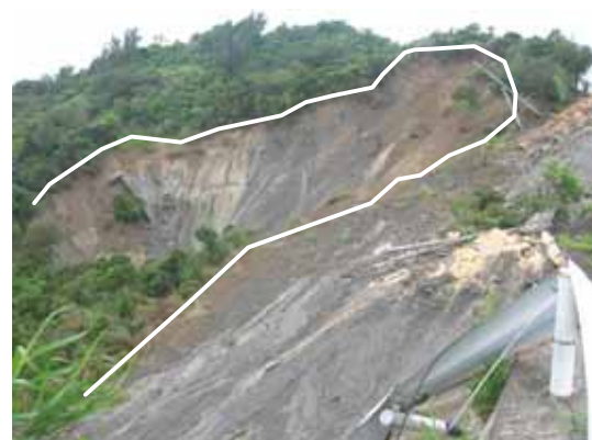
写真 - 5 6月12日夜から6月13日朝にかけて発生した頭部右翼側の二次すべり(6月13日午前10時頃撮影)
