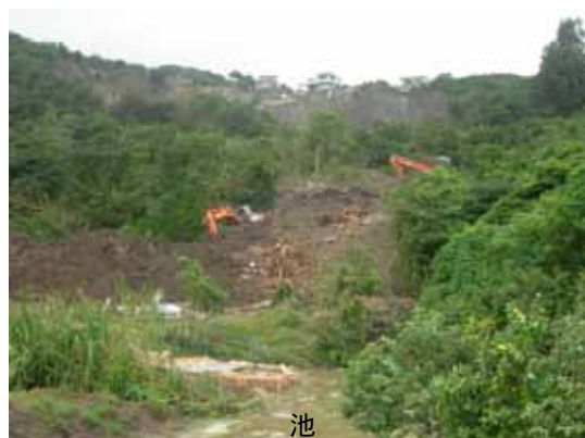
写真 - 8 舌端部左翼側部形成された池。背後の崖は滑落崖(6月13日正午頃撮影)
