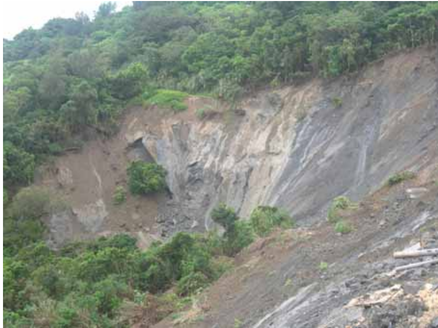
右翼側で発生した二次すべりの滑落崖（13日午前）
