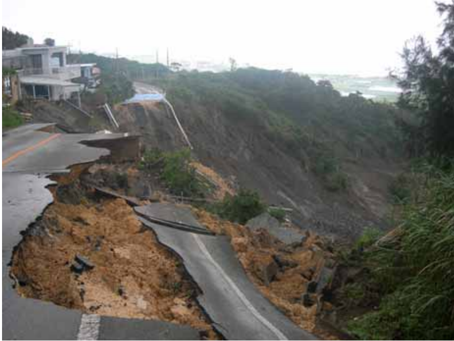
地すべり頭部の村道と住宅（13日午前）
