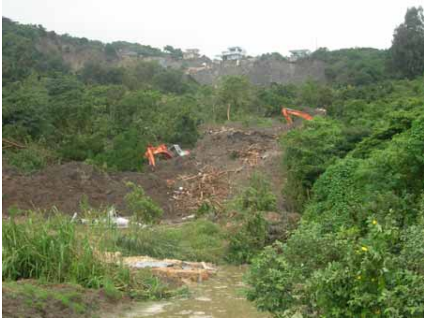
すべりブロック中腹にできた池と被災した重機（13日午前）
