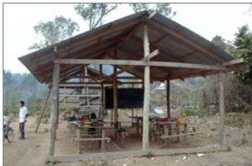
壁も床もない校舎
