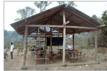
壁も床もない校舎
