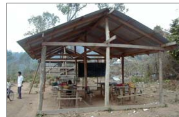
壁も床もない校舎
