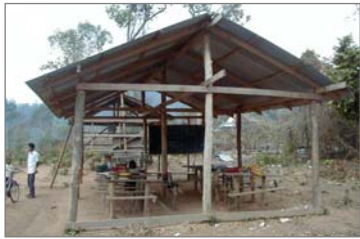
壁も床もない校舎
