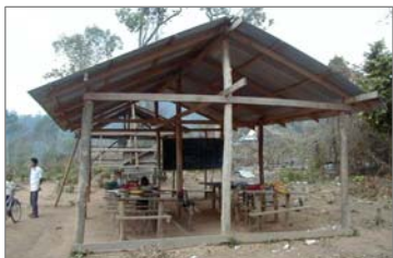
壁も床もない校舎
